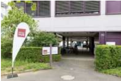
Das Gebäude des Impact Hub Basel vor dem Umbau, Münchensteinerstrasse 274A, 4053 Basel
